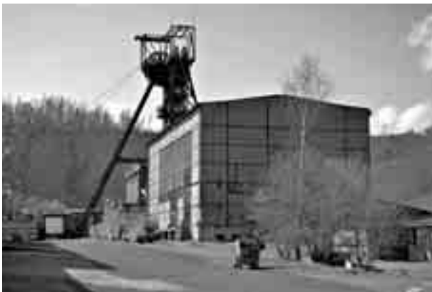
Zdvojená těžní věž uranové šachty č. 15, Brod (Příbram), 1242,6 m hluboké. Zpracován plán likvidace závodu, vážně ohrožena, v nedávné době zničeny těžní stroje demontáží mědi. Na šachtě 15 podnik DIAMO svého času uvažoval zřídit muzeum těžby uranu a shromažďoval zde různou techniku a je velká škoda že se tento projekt nerealizoval. Haldy v pozadí reprezentují dočasnou příbramskou montánní krajinu, výhledově budou odtěženy. Foto: M. Přibil, 2012
