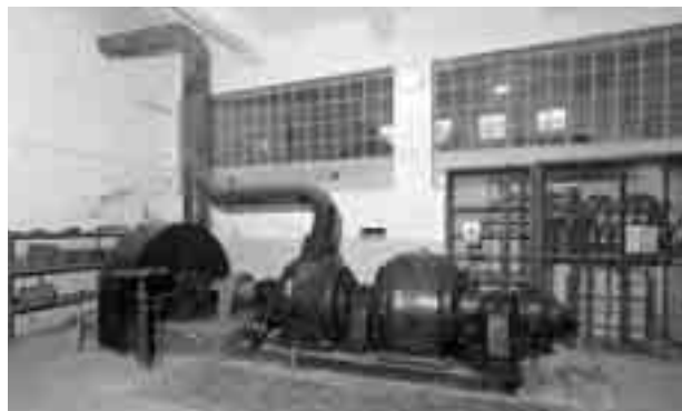
Důl Centrum, strojovna šachty C1. Měnič na stejnosměrný proud systému Ilgner (Ward-Leonardovo soustrojí se setrvačником), kulturní památka. Foto: Martin Přibil, 2016
