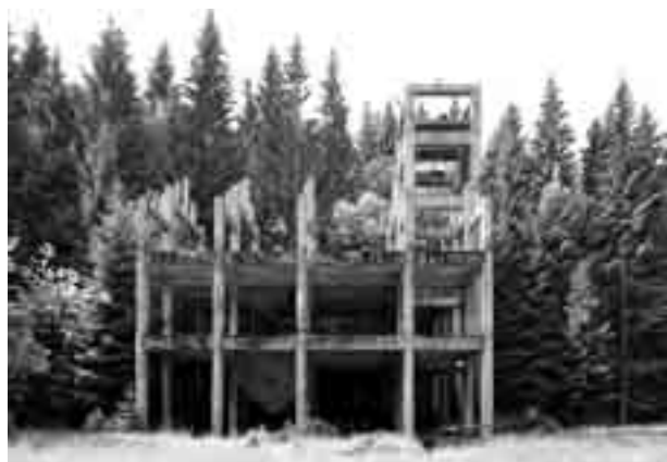
Železobetonová těžební věž na Přebuzi, ruina nekontrolovaně chátrající, podobně jako důl na nedaleké Rolavě. Foto: M. Přibil, 2014
