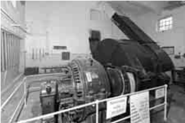
Důl Centrum, strojovna šachty C1. Těžní stroj Škodovy závody, 1927 - kulturní památka. Foto: Martin Přibil, 2016
