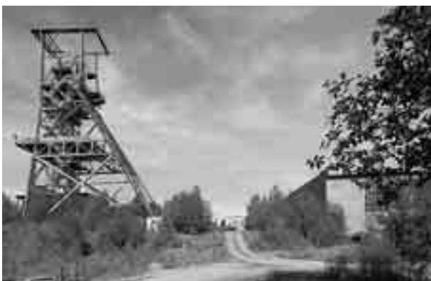
Těžní věž uranové šachty č. 11 A, Bytíz (Příbram), která byla 1503,6 m hluboká. Dochované technologie, strojovna, kompresorovna od s. p. DIAMO kupuje (2016/17) SČ kraj pro Hornické muzeum Příbram. Foto: Martin Přibil, 2009
