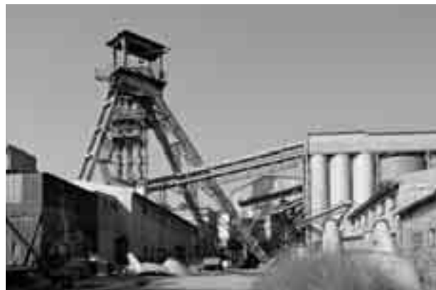
Horní Benešov, šachta Obránců míru, soukromý areál. Atypicky podepřená věž vznikla otočením zhlaví věže po poklesu strojovny vlivem poddolování. Demontováno na jaře 2016 z důvodů špatného statického stavu věže. Impuls k demontáži byly m.j. obavy, aby těžní věž nebyla navržena za Kulturní památku a nezůstala firmě jako zátěž co polyká peníze na opravy a údržbu. Foto: Martin Přibil, 2011
