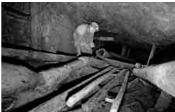
Dřevěné dvojčinné pístové čerpadlo v dole Alt Hackelsberg (Gottes Gab) bylo poškozeno nekontrolovaným vstupem speleologů a jiných milovníků adrenalinové zábavy do opuštěných dolů u Zlatých Hor. Foto: Martin Přibíl a Karol Šmehil, 2009.
