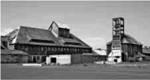
Mechanismus zkázy dolu Čínovec: Ukončení těžby, prodej povrchového areálu, zástava majetku, bankrot. Rozkradení plechové střechy a kovových prvků, zatékání vody a poškození stavebních konstrukcí mrazem. Výkup pozemků a ruiny dolu obcí Dubí, žádost o dotace, likvidace a rekultivace. Rok 2006. Foto: Martin Přibil.
