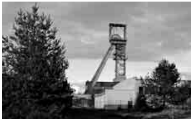
Těžní věž uranového dolu Hamr, DIAMO TTÚ, Stráž pod Ralskem byla demontována v létě 2015. Foto: Martin Přibil, 2008
