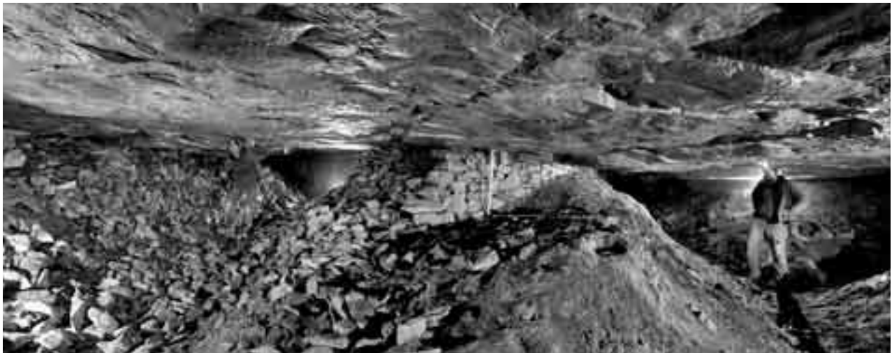
Podzemní lom v ulici V Kroupovci ve Vehlovicích u Mělníku, kde se dobývala opuka (spongilitické slínovce) pro stavební a kamenickou výrobu. V minulosti byly podzemní lomy svázány s pozemkem včetně způsobených škod a pod báňské právo nespadaly. Foto: Martin Přibíl, 2011
