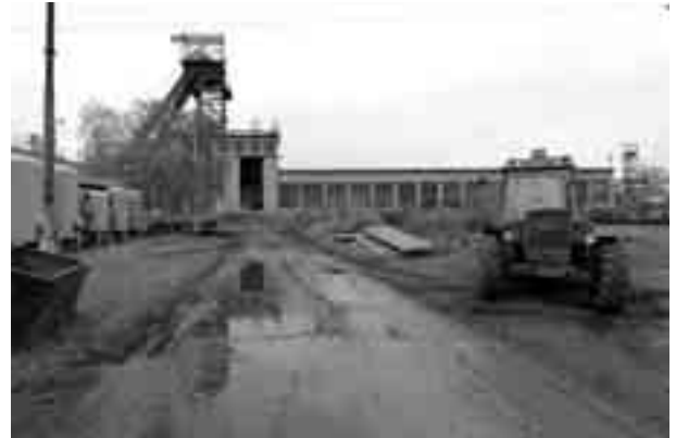
Důl Centrum, šachta C2, zcela vpravo šachta C1, vše Kulturní památka včetně strojoven, těžních strojů, měničů, koupelen, zásobníků na uhlí. Foto: Martin Přibíl, 2016
