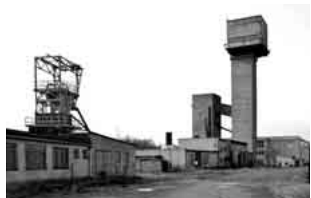
Měděnec, vlevo ocelová těžní věž pro fárání mužstva, v pozadí žb. skipová těžní věž na dopravu těživa ve skipové nádobě. Soukromý areál (v exekuci, zástavní práva), zatím snad není ohroženo, poslední rudní žb. skipověž v ČR, úvaha o vyhlášení KP. Martin Příbil, 2011
