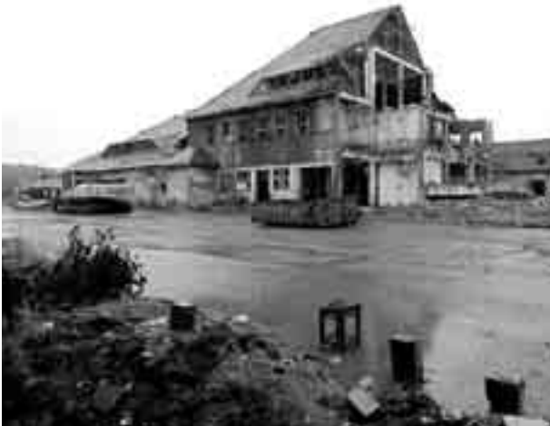
Demolice dolu Čínovec v červnu 2011. Projekt „vznikl za podpory MŽP a ministra Tomáše Chalupy, předmětem podpory bylo bourání a demolice nevyužívaných objektů se špatným stavebně technickým stavem v areálu Rudné doly Čínovec. Realizací tohoto projektu došlo k odstranění komunálních a nebezpečných odpadů umístěných v demolovaných budovách a likvidaci železobetonové stoly zasypaním popílkem“ 10 . Suma 36 753 372 Kč. Foto: Martin Přibil.
