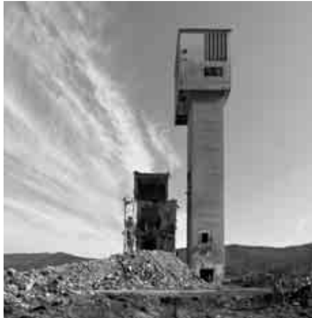
Skipověž rudného dolu Zlaté Hory během demoličních prací v roce 2011. Na lokalitě se průběžně uvažuje o obnově těžby zlata. Foto: Martin Přibil.
