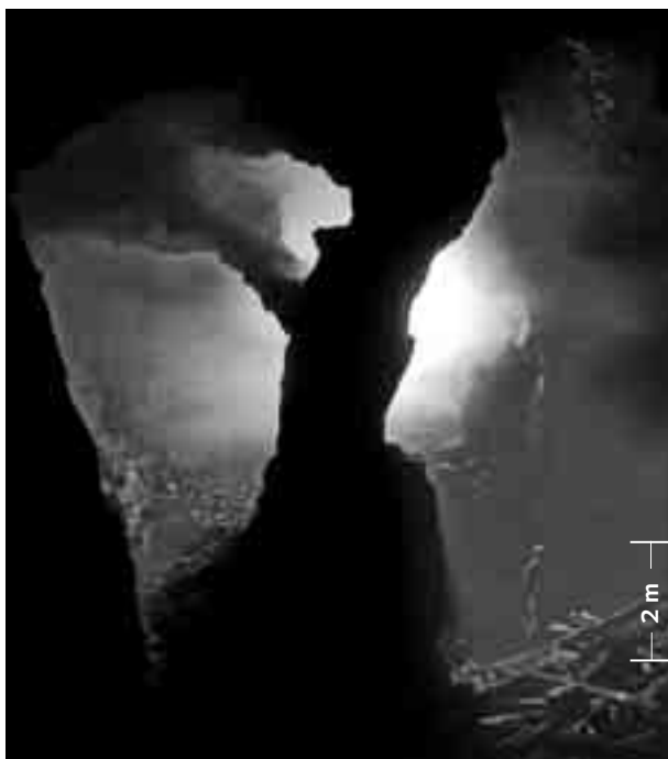
V roce 2013 zřícený pilíř v dole Johann na Zlatém kopci je výsledek nepromyšleného pokusu o zpřístupnění nestabilního dolu motivovaného hysterickou snahou dostat české Krušnohoří do Unesco i za cenu poškození či zničení historického důlního díla. Tento příklad demaskuje pravé motivy i cíle této „cesty do UNESCO“, kde jde hlavně o dotační a turistický byznys, nikoliv památky jako takové. Nepomáhejme roztáčet dotační mlýny! Foto: Martin Přibíl, 2003.
