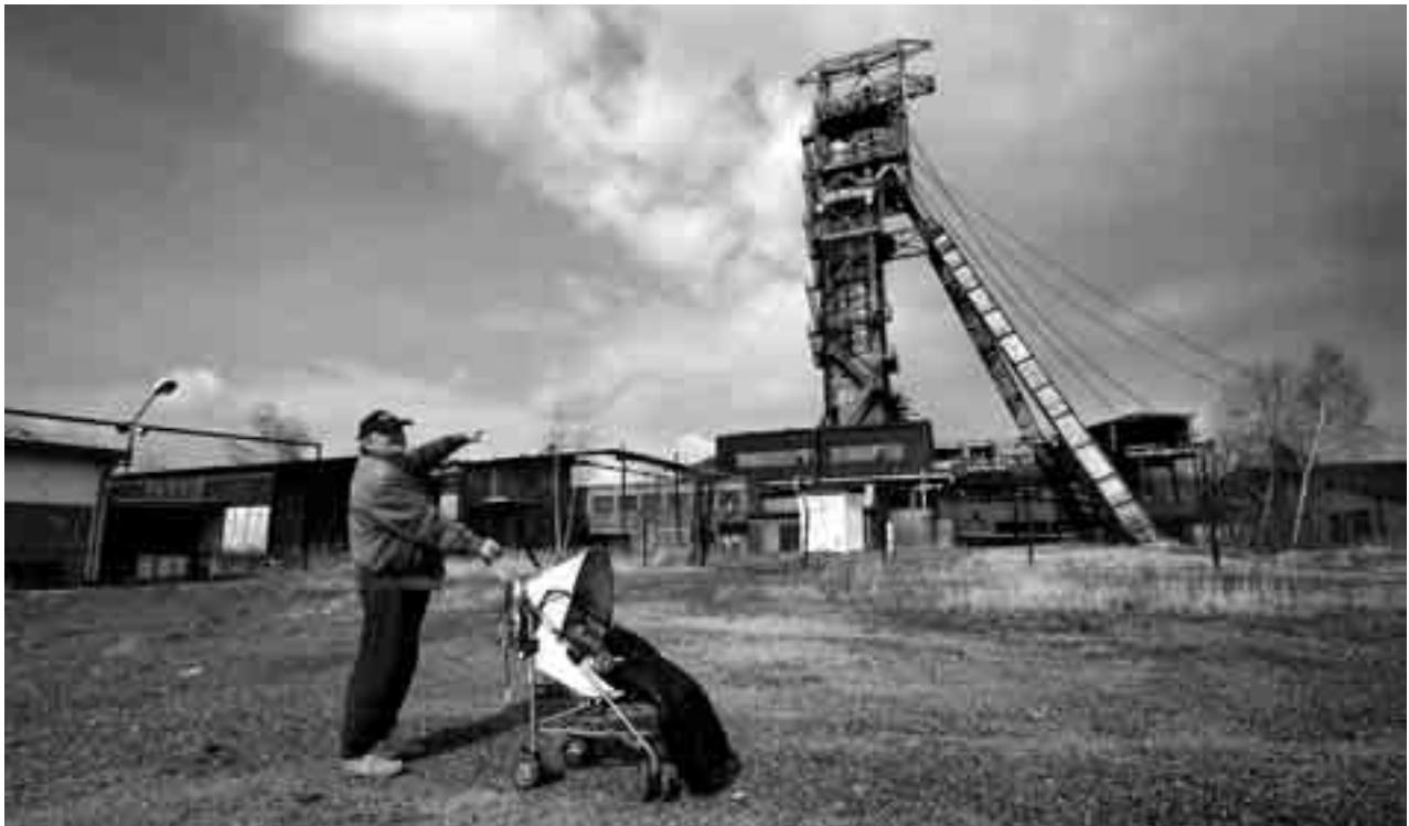
Jeden ze symbolů čs. hornictví, těžní věž uranové šachty č. 16, Háje (Příbram), která s hloubkou 1838,4 metru byla nejhlubší rudnou jámou evropského hornictví (tj. šachetní stvol zde byl v jedné kolmé délce 1838,4 m, uranové doly v NDR byly absolutně i relativně [m n.m.] hlubší). Slouží jako nosič antén telefonních společností, byla by vynikající rozhlednou. V nedávné době poškozeny těžní stroje rabováním mědi. Foto: MP, 2008
