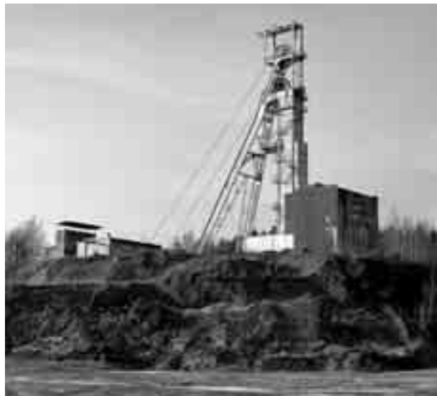
Šachta R3 Jasan, činná šachta (útěková cesta) uranového dolu Rožná. Elegantní krásná dominanta, v případě budoucí konverze na rozhlednu zde nebude levná údržba. Foto: Martin Přibil, 2016
